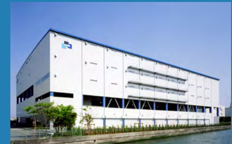
新東京物流センター
